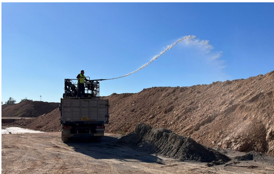
Εικόνα 9: Εφαρμογή υδροσποράς σε αποθέσεις υλικών
