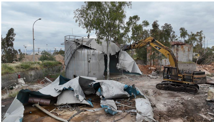
Εικόνα 4: Καθαίρεση παλιών δεξαμενών καυσίμων
